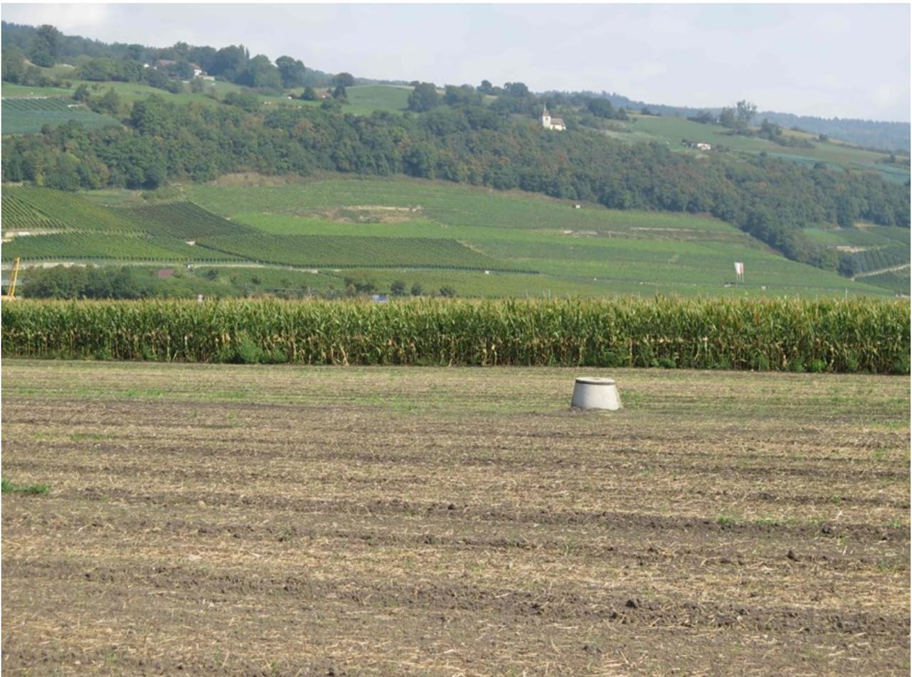
**Abb. 2:** Die Mineralisierung des Torfkörpers und mechanische Kompaktion verursachen Geländesackungen. Sichtbar wird dies beispielsweise an freigelegten Entwässerungsschächten (hier bei Cressier NE). Seit der 1. Juragewässerkorrektion (1868-1891) ist die Geländeoberfläche im Seeland vielerorts um über einen Meter abgesunken.
