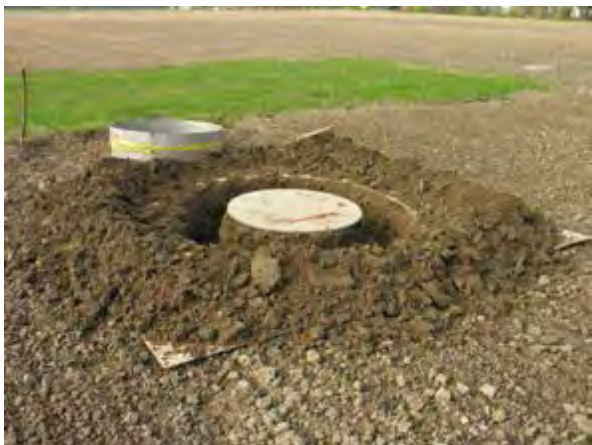
Einbau der oberen Zylinderhülse, die für die maschinelle Bodenbearbeitung abgenommen wurde.
